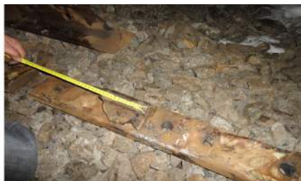
Foto 3 : Fragmentul rupt din șină
