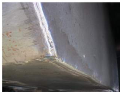
Fig. 6 – Urme de lovire pe colțul rezervorului de combustibil
