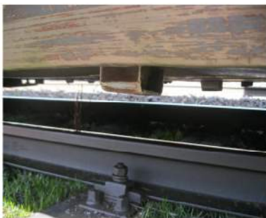
Fig. 7 – Urme de lovire pe suportul de repaus al rezervorului, din față sens mers
