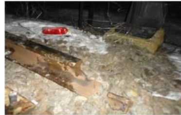
Foto 2 : Capătul rupt al șinei din alcătuirea joantei izolatoare lipite
