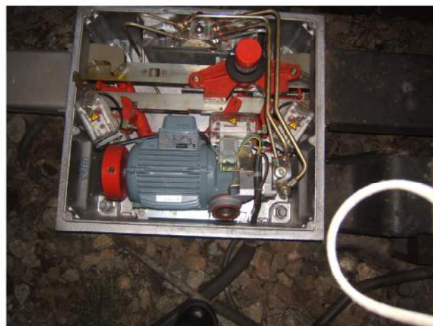
foto 1. Mecanism de manevrare macaz nr. 27
